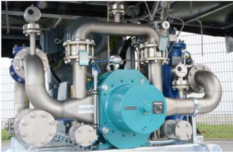
Drehkolbenpumpe und Variodeckel in ATEX-konformer Bauweise
