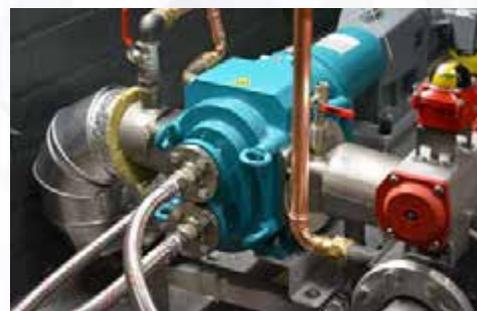
*Pompe BLUEline équipé d'un corps de réchauffage et flasque avant de réchauffage*
