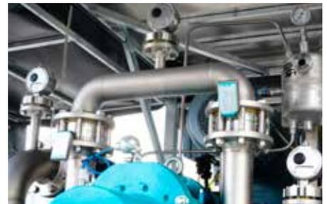
Überdruckschutz durch Bypass mit Berstscheiben
