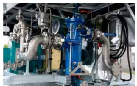
Filteranlage mit Differenzdruckmessung
