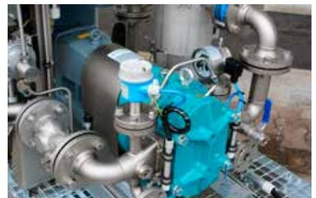
Druckmessung mittels Drucktransmitter
