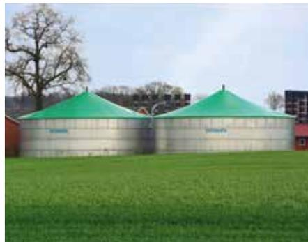
*gasdichte Spannfolienabdeckung (ein-oder zweischalig)*
